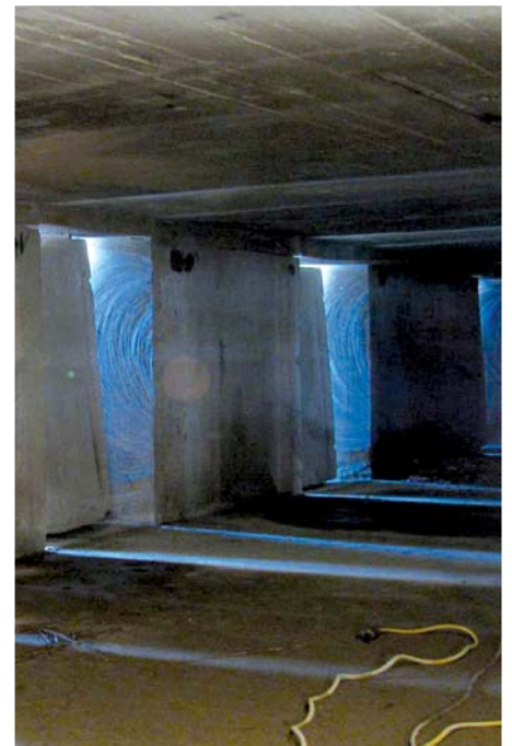
Hier wurden die Betonblöcke für die Fenster und Türen herausgetrennt und kurz danach wurden die Blöcke mit einem Kran nach außen gezogen.
