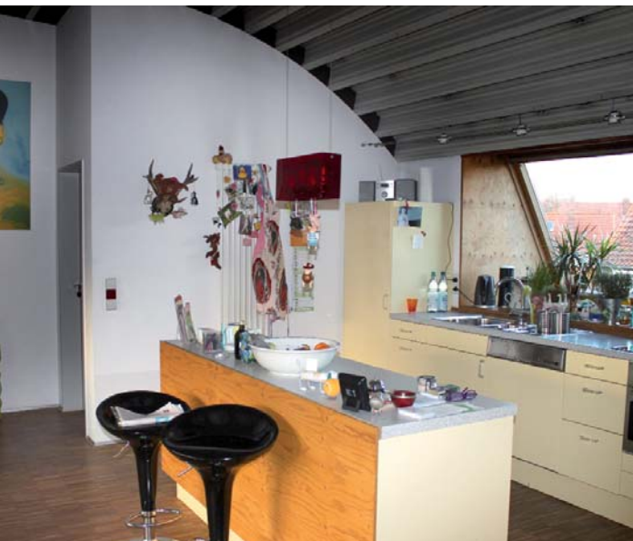
Beste Aussichten beim Kochen im Penthouse. Der aus tonnenförmigen Wellblech bestehende Aufbau ist Dach und Wand zugleich.
