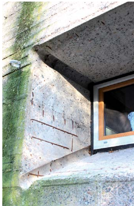
1,10 Meter sind die alten Stahlbetonwände dick. Mithilfe einer Seilsäge wurden die Fensteröffnungen in die Mauer geschnitten
